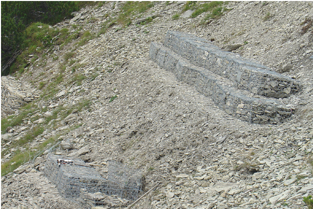
Mauern mit Steinkörben A typical terraced wall with gabions
