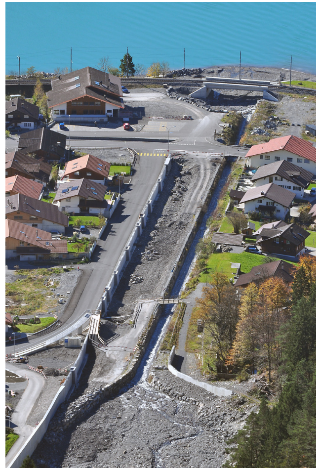
Vergleich des alten und des neuen Gerinnes auf dem Kegel (links) und Foto aus der Bauphase (rechts) Comparison of the original and new channel profile on the debris fan (left) and a photograph during the construction phase (right)
