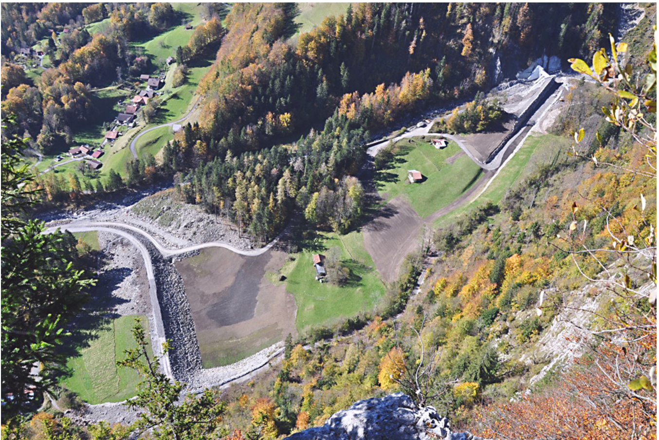
Gesamte Rückhalteanlage Undersitsch mit dem Ausleitbauwerk oben rechts im Bild, im Anschluss das Überleitgerinne in den Rückhalteraum, der durch den Damm begrenzt wird und in ein Rückleitgerinne führt, damit im Ereignisfall Wasser zurück in den Glyssibach fließen kann.
