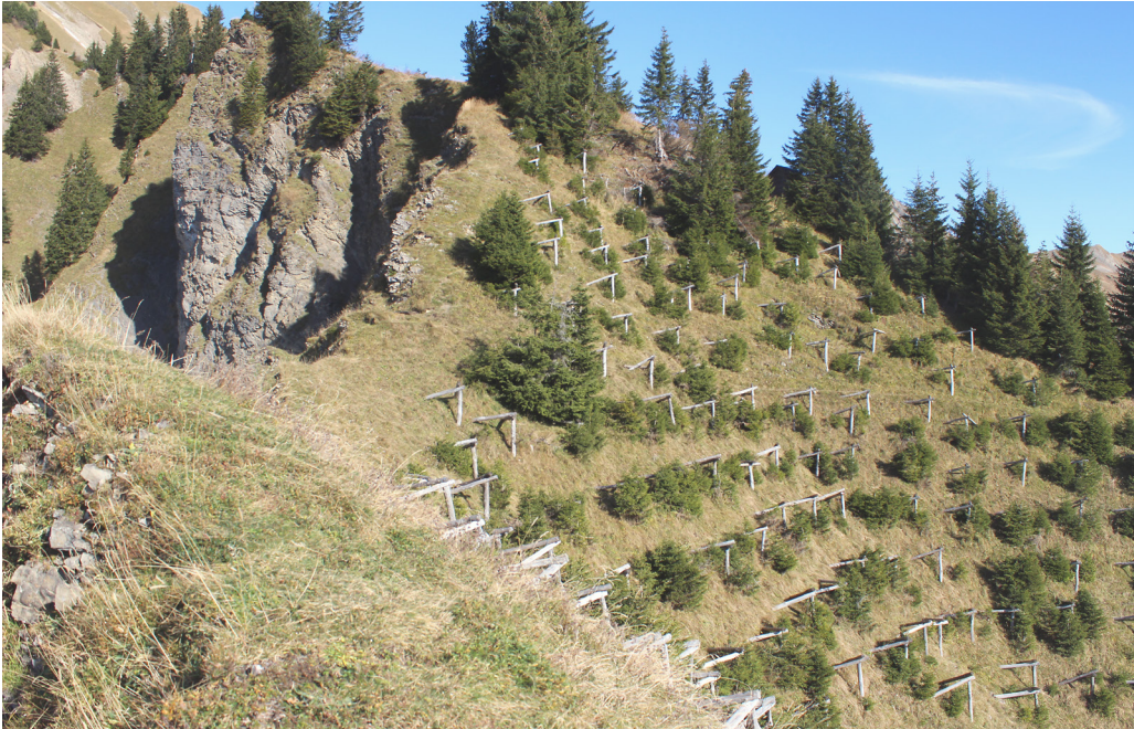
Hochlagenaufforstung im Schutz von Gleitschneeverbauungen A typical high-elevation afforestation with snow gliding tripods
