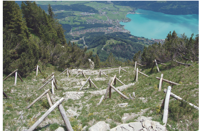
Gleitschneeschutz mit Dreibeinböcken Tripod structures to prevent snow gliding
