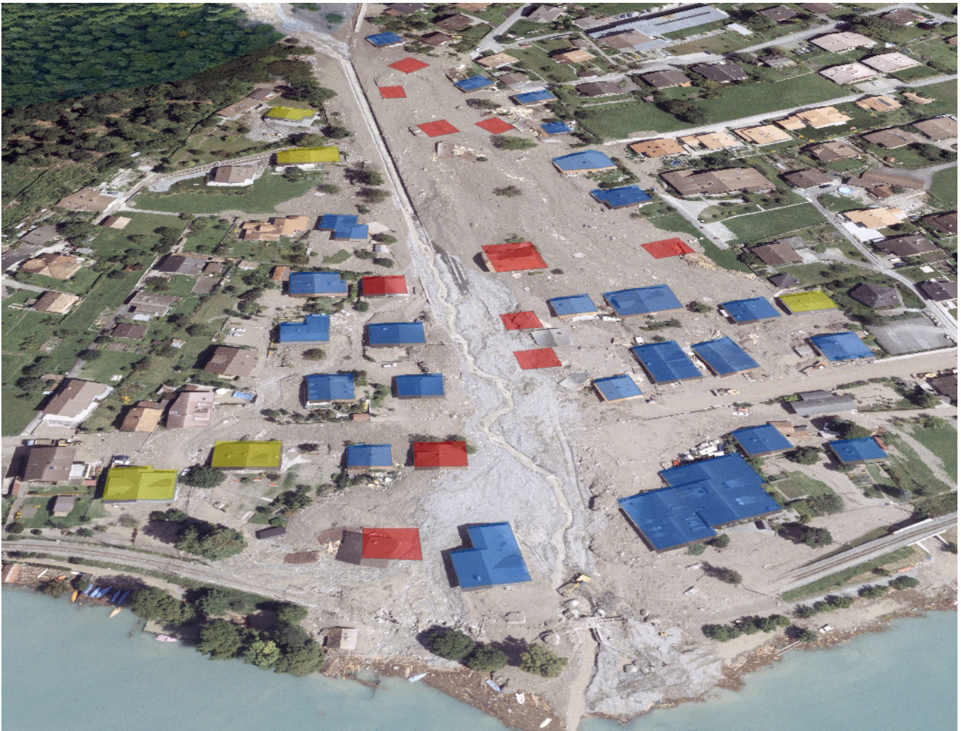
Übermurter Wildbachkegel am Glyssibach nach dem Unwetter 2005. Rot = vollständig zerstört, blau = erheblich beschädigt, gelb = leicht beschädigt. The debris fan of Glyssibach after the 2005 event. Red: buildings that were destroyed; blue: buildings with severe damage; yellow: buildings with light damage.
