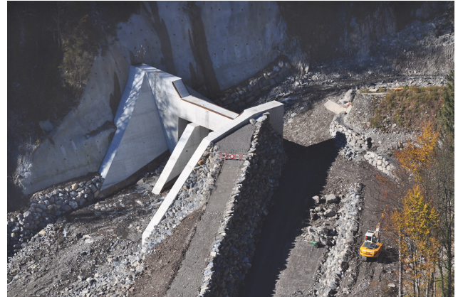
Ausleitbauwerk in Realisierung Construction of the diversion channel
