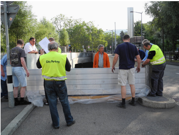
Notfallübung mit mobilem Hochwasserschutz beim Parkhaus Gessnerallee.
