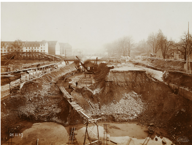
1919: Verlegung der Sihl mit dem Neubau der linksufrigen Zürichseebahn. 1919: Repositioning the Sihl and construction of the railway line along the left bank of Lake Zurich.
