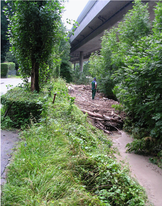
Hochwasser 2005: Schwemmholz unter der Sihlhochstrasse. Flooding in 2005: woody debris under the elevated motorway.
