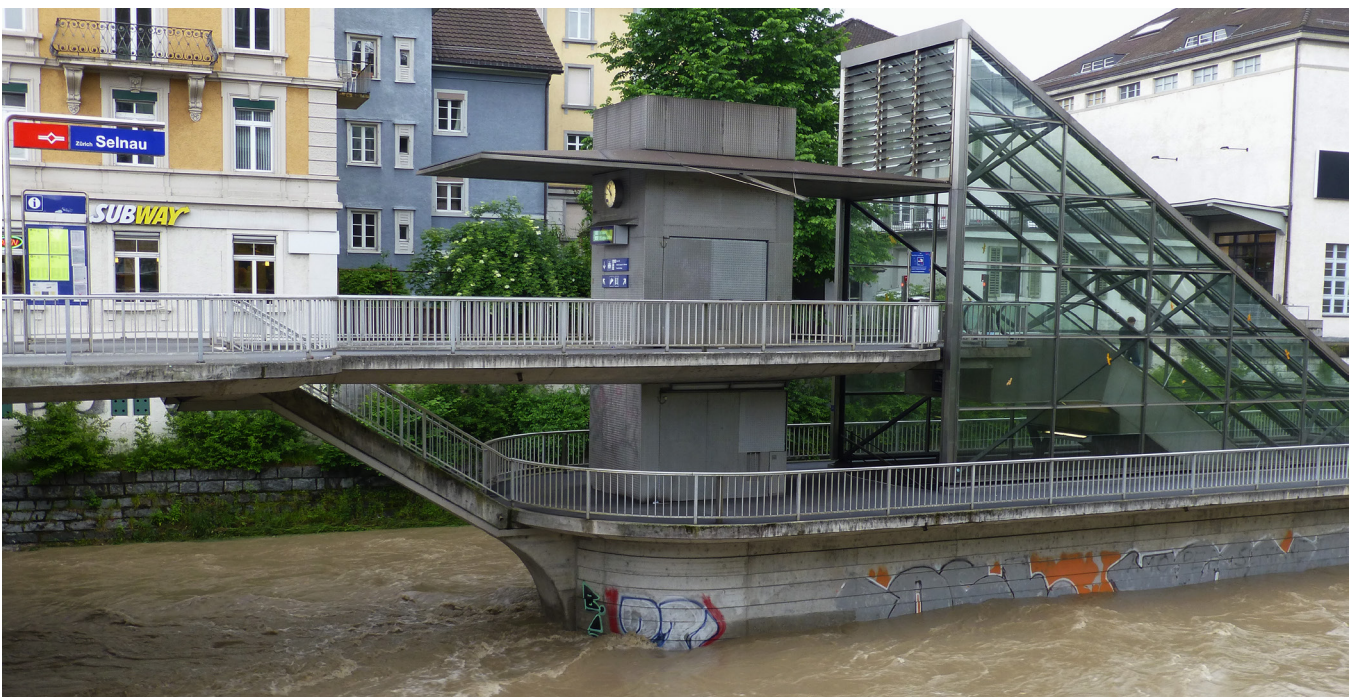
Bei einem 300-jährlichen Hochwasser würden die Zugänge zum Bahnhof Selnau überflutet. In a 300-year event the entrance to the Selnau railway station would be flooded.
