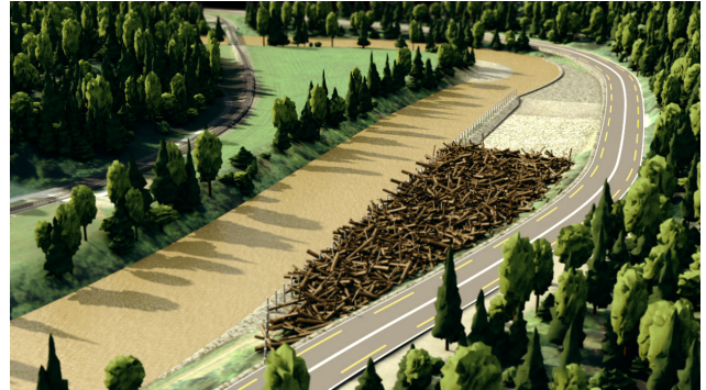
Der Parallelrechen in der Sihl hält bis zu 95% des Schwemmholzes sicher zurück. The rake barrier in the Sihl was dimensioned to retain up to 95% of transported debris.
