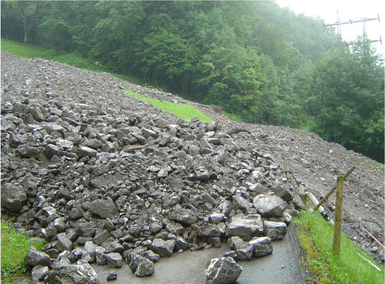
Die Murgänge im Juni 2009 verschütteten die einzige Zufahrt zum Bergdorf Riemenstalden an mehreren Stellen (Foto: Awn SZ). The debris flows in June 2009 affected the only connecting road to Riemenstalden in three places (Photo: Awn SZ).
