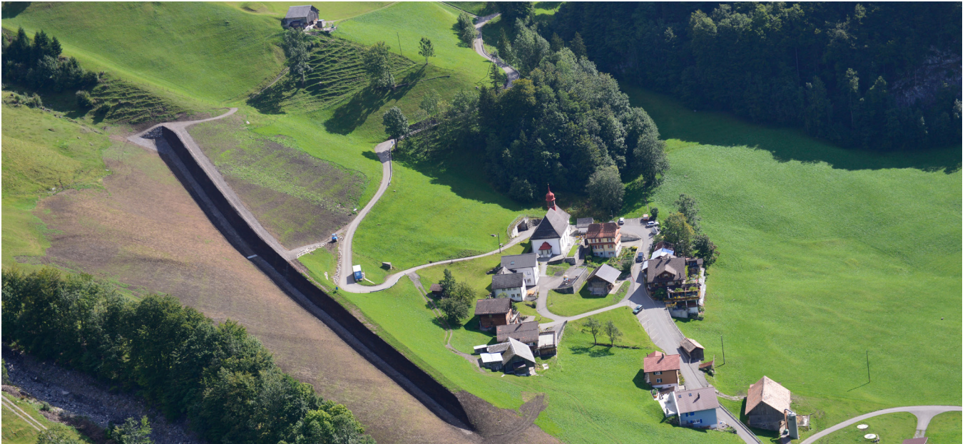
Ein 260 m langer und 5.5 m hoher Schutzdamm schützt das Dorf Riemenstalden vor Lawinen, Sturzprozessen und Murgängen (Foto: AMFZ SZ). A 260-m long and 5.5-m high protection dam was built to protect Riemenstalden from avalanches, rockfall and debris flows (Photo: AMFZ SZ).
