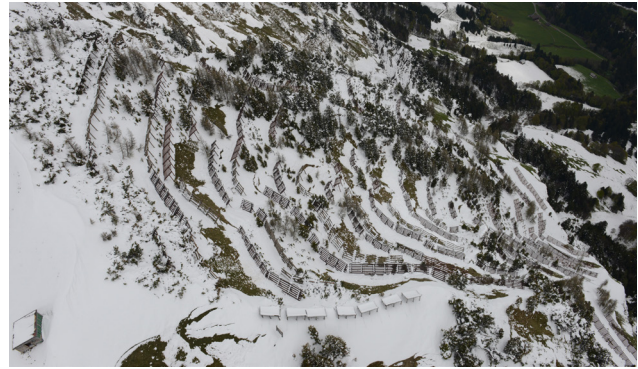
Lawinverbauungen im Gebiet Grosswand, oberhalb Riemenstalden Dörfli (Foto: AMFZ SZ). Avalanche defense structures on the Grosswand above the village Riemenstalden (Photo: AMFZ SZ).
