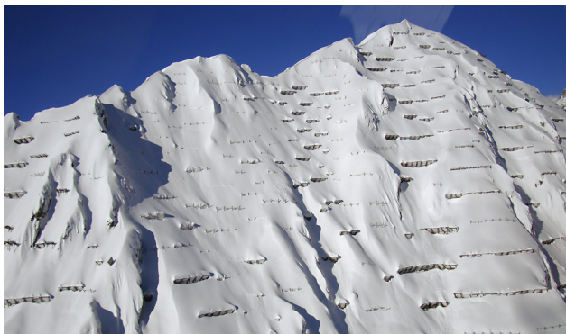
Eingeschneite Lawinenverbauung am Geissberg im Winter 2012 (Foto: H.M. Henny) Snow-filled avalanche supporting structures on Geissberg in the winter of 2012 (H.M. Henny)
