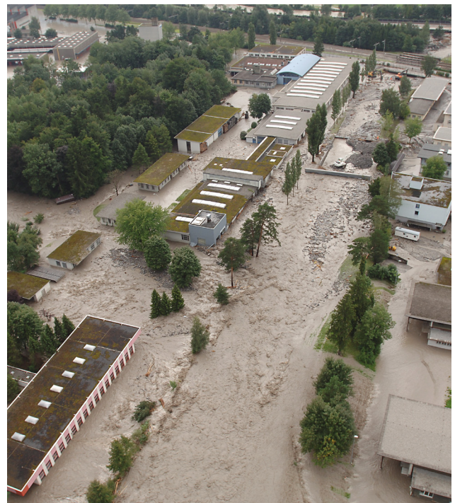
Überlaufender Schächenkanal Overflow channel in the Schächen
