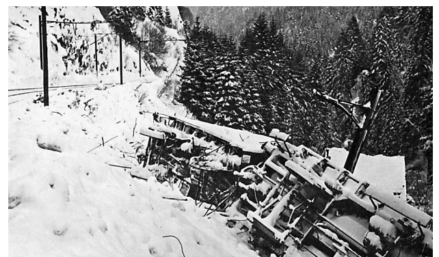
Das Lawinenereignis vom 31. Januar 1942 hob Güterwagons aus den Schienen (aus: V. Sicher, 1973). A derailed cargo train after the avalanche on 31 January 1942 (V. Sicher, 1973).
