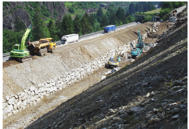
Der neue Schutzdamm während der Bauphase 2007 The new catching dam during construction in 2007
