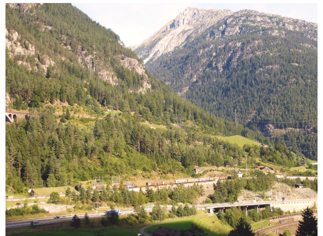
Nationalstrasse und Bahn im Schutz des Dorfbannwaldes von Wassen. Die Geleise der SBB queren den Hang in diesem Abschnitt dreimal.
