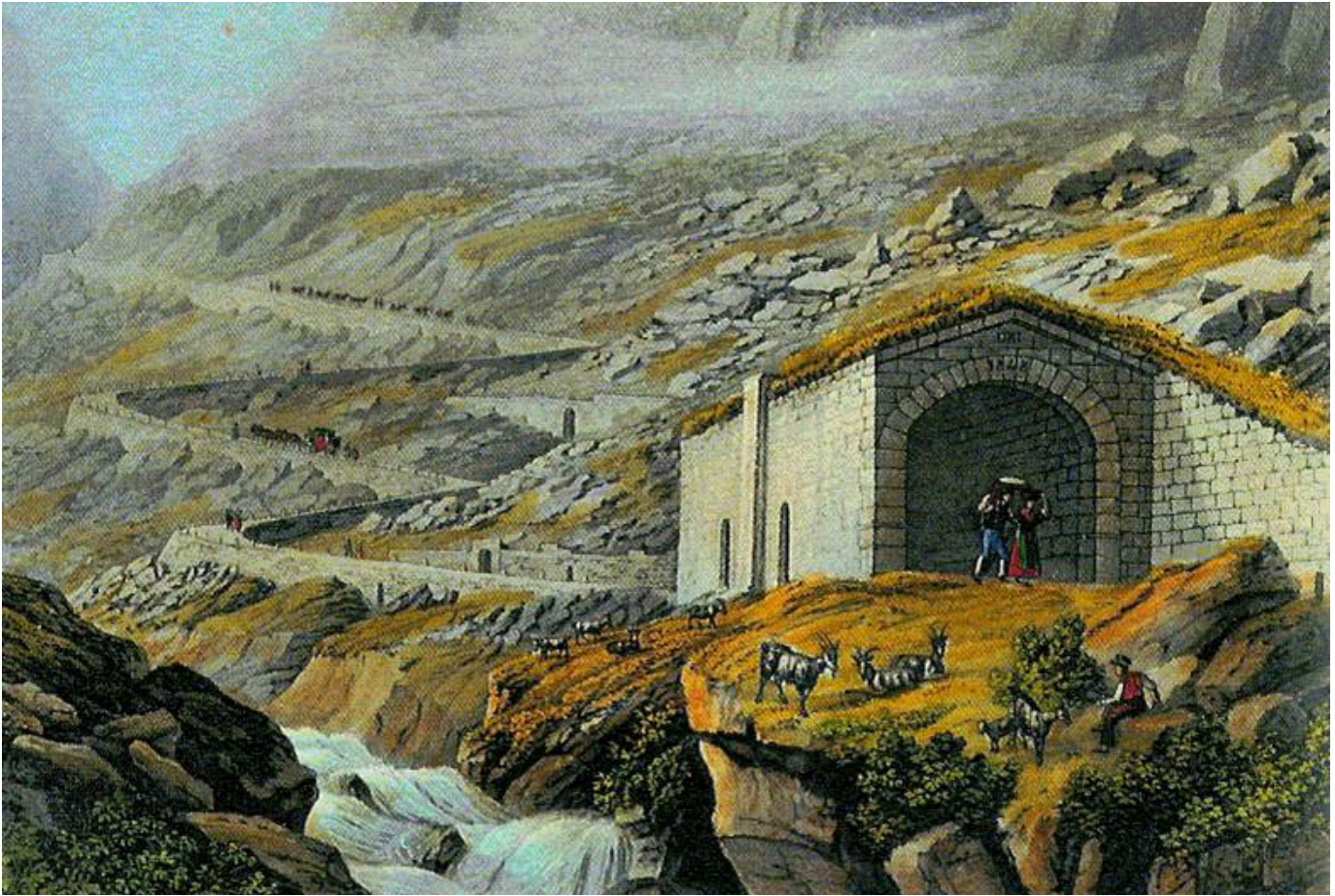
Jostbachgalerie: erste Lawinengalerie im Kanton Uri Gallery near Jostbach: the first avalanche gallery in Canton Uri
