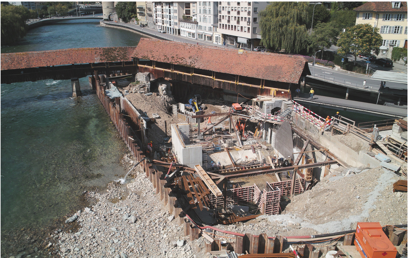
Reusswehr, Neubau Seitenwehr. Aufnahme vif 7. September 2009. Reuss weir, reconstruction of the gated weir (vif, 7 September 2009)
