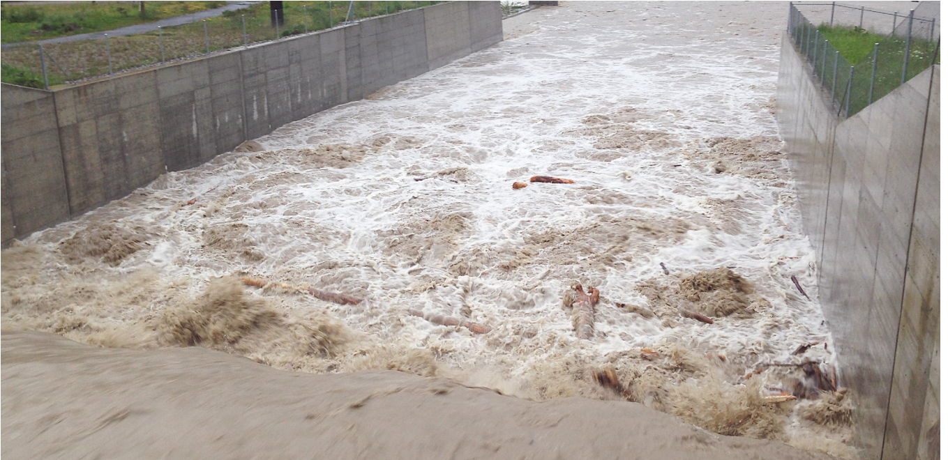
Stauklappe geöffnet, Ausleitung Schwemmh Holz aus Flachsee in den Holzrückhalteraum, Ettisbühl, Malers, Aufnahme vif 1. Juni 2013. The flood gates on the holding basin can be opened to direct debris from the Flachsee into the retention area, Ettisbühl, Malers (vif, 1 June 2013)
