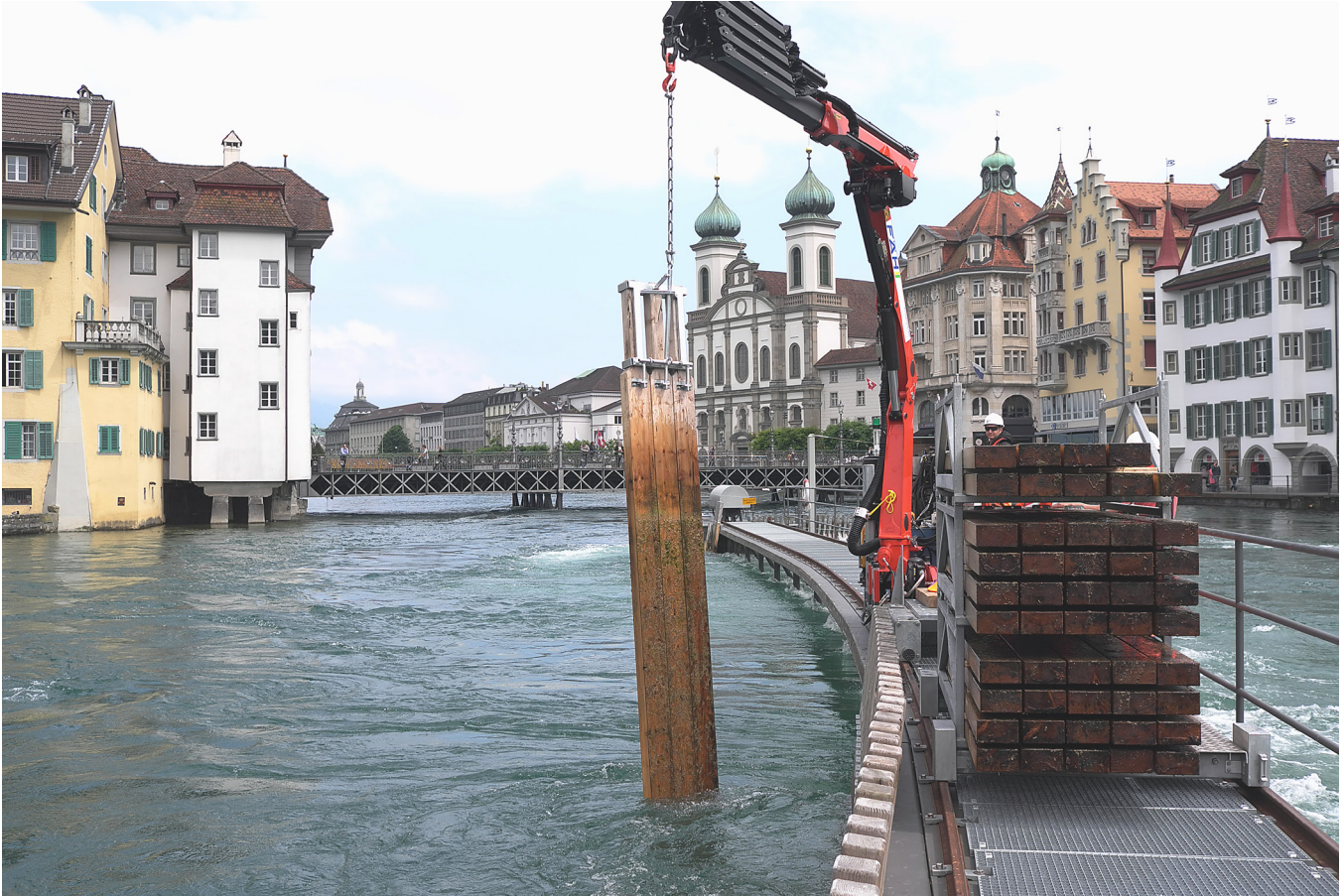
Reusswehr, Nadelsetzgerät am Längswehr im Einsatz. Aufnahme vif 5. Juni 2012. Reuss weir, automatic device in operation on the longitudinal section of the stave weir (vif, 5 June 2012)
