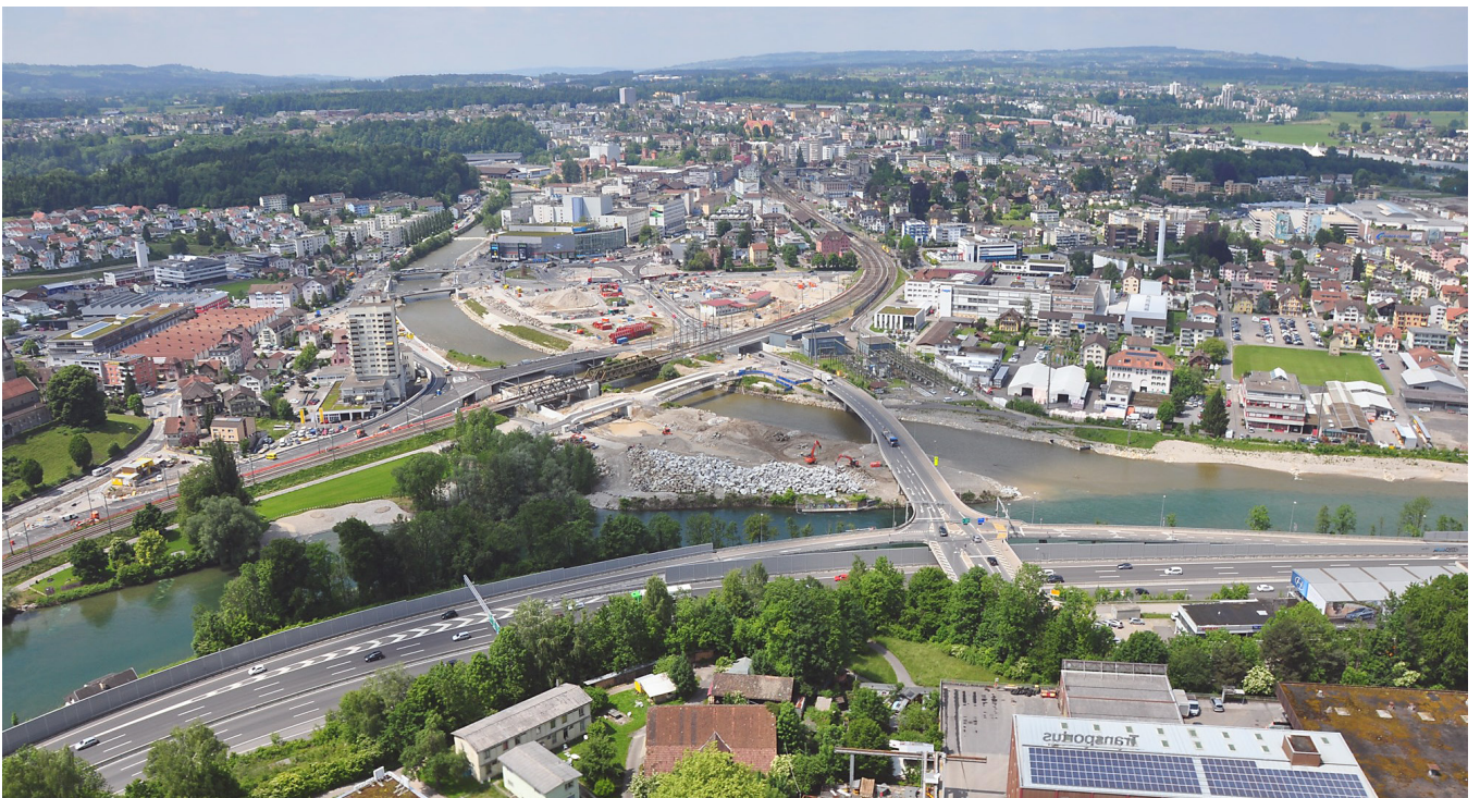
Übersicht Mündung der Kleinen Emme in die Reuss, Seetalplatz, Emmen. Aufnahme vif 27. Mai 2015. Overview of the confluence into the Reuss, Seetalplatz, Emmen (Verkehr und Infrastruktur [vif], 27 May 2015)
