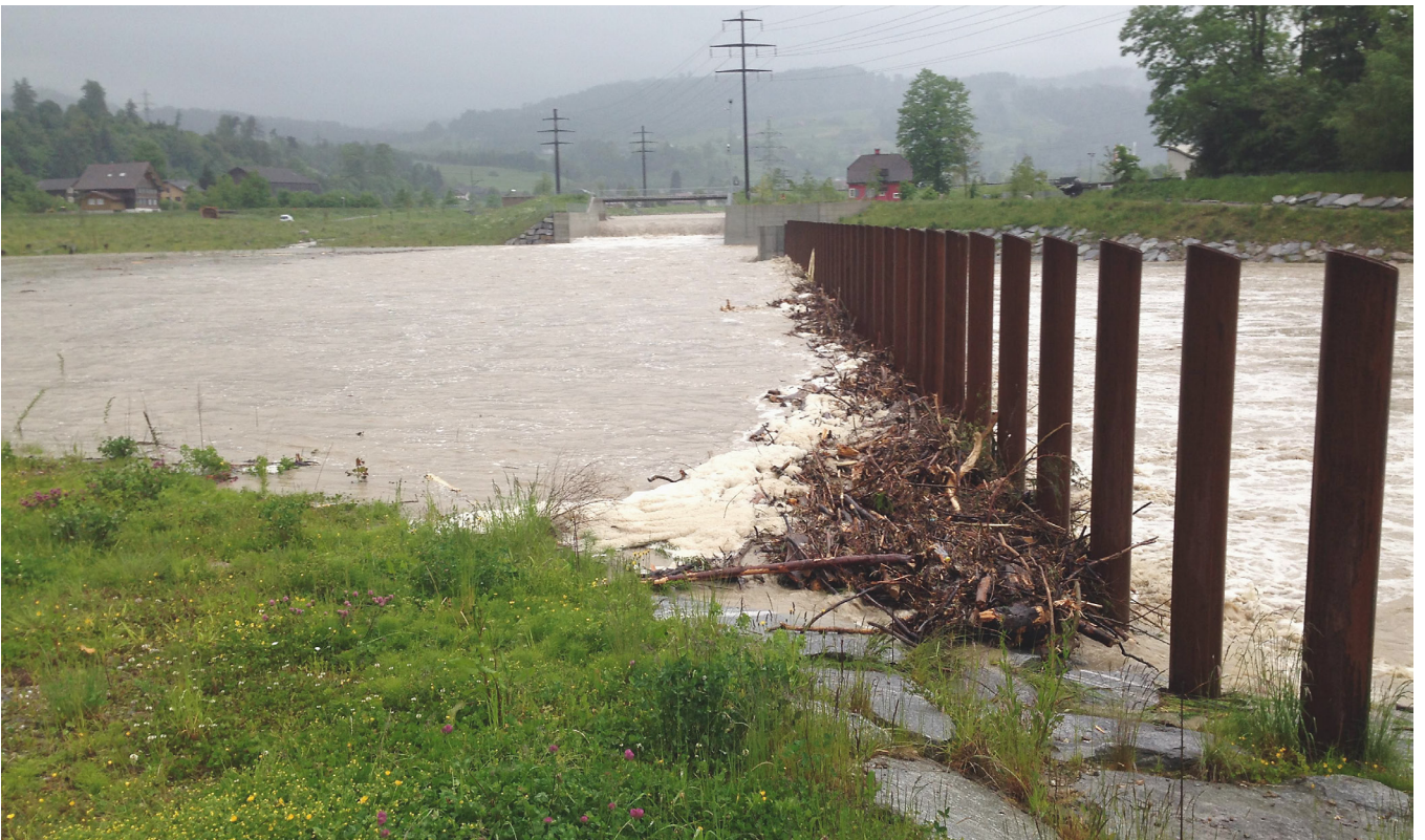
Rechen 1, zurückgehaltene Holzmenge ca. 400 m 3 , Ettisbühl, Malers. Aufnahme vif 1. Juni 2013. Rake barrier 1, retained volume ca. 400 m 3 , Ettisbühl, Malers (vif, 1 June 2013)
