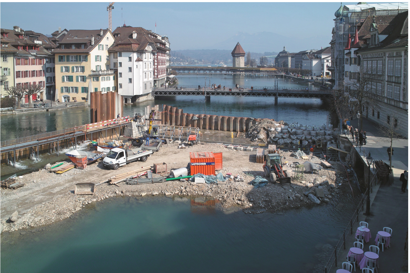
Reusswehr, Neubau des Stirnwehrfundamentes. Aufnahme vif 10. September 2012. Reuss weir, reconstruction of the stave weir foundation (vif, 10 September 2012)
