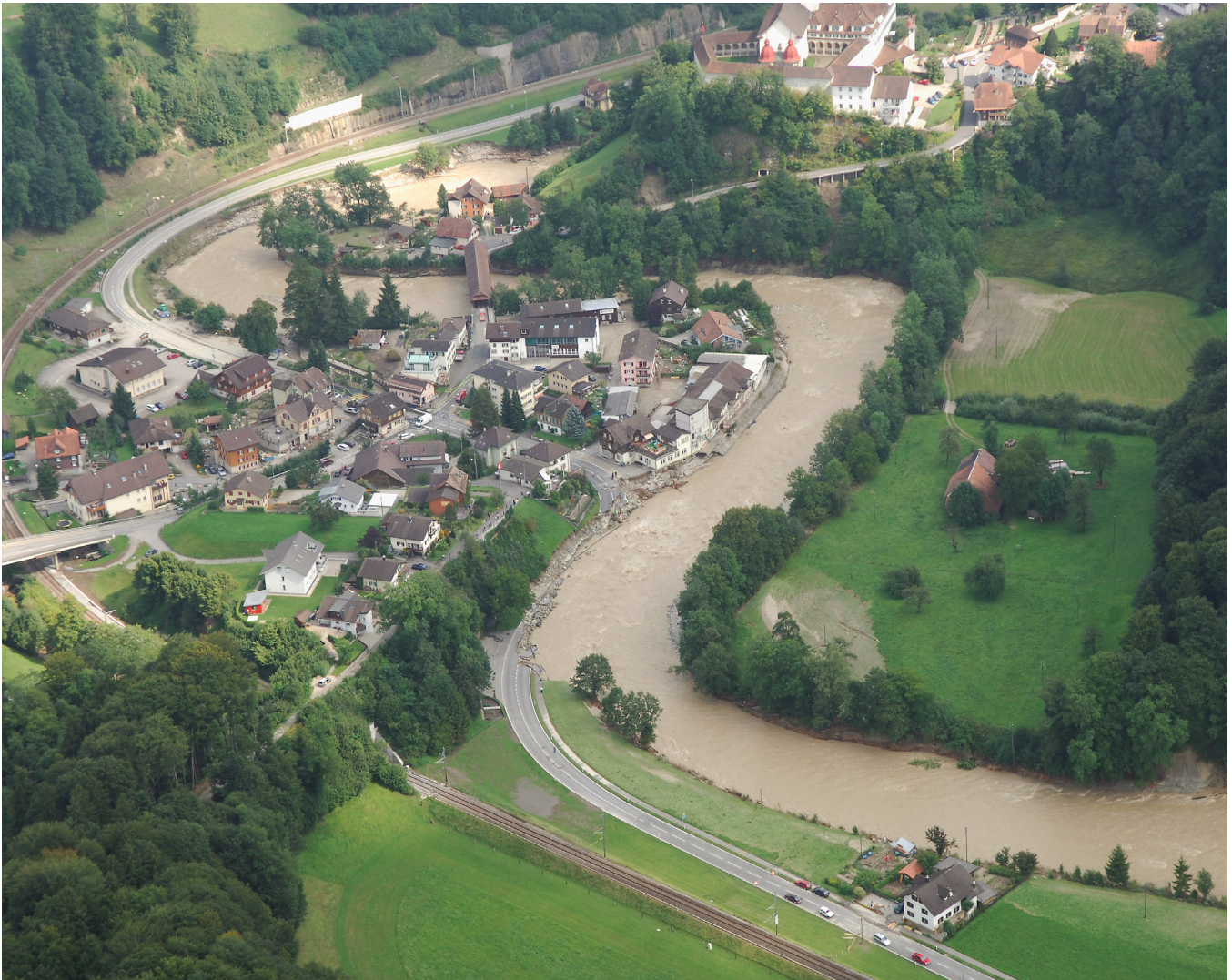
Weggerissene Kantonsstrasse, Kleine Emme, Werthenstein. Aufnahme Schweizerische Luftwaffe 22. August 2005. Damage to the main road, Kleine Emme, Werthenstein (Swiss Air Force, 22 August 2005)
