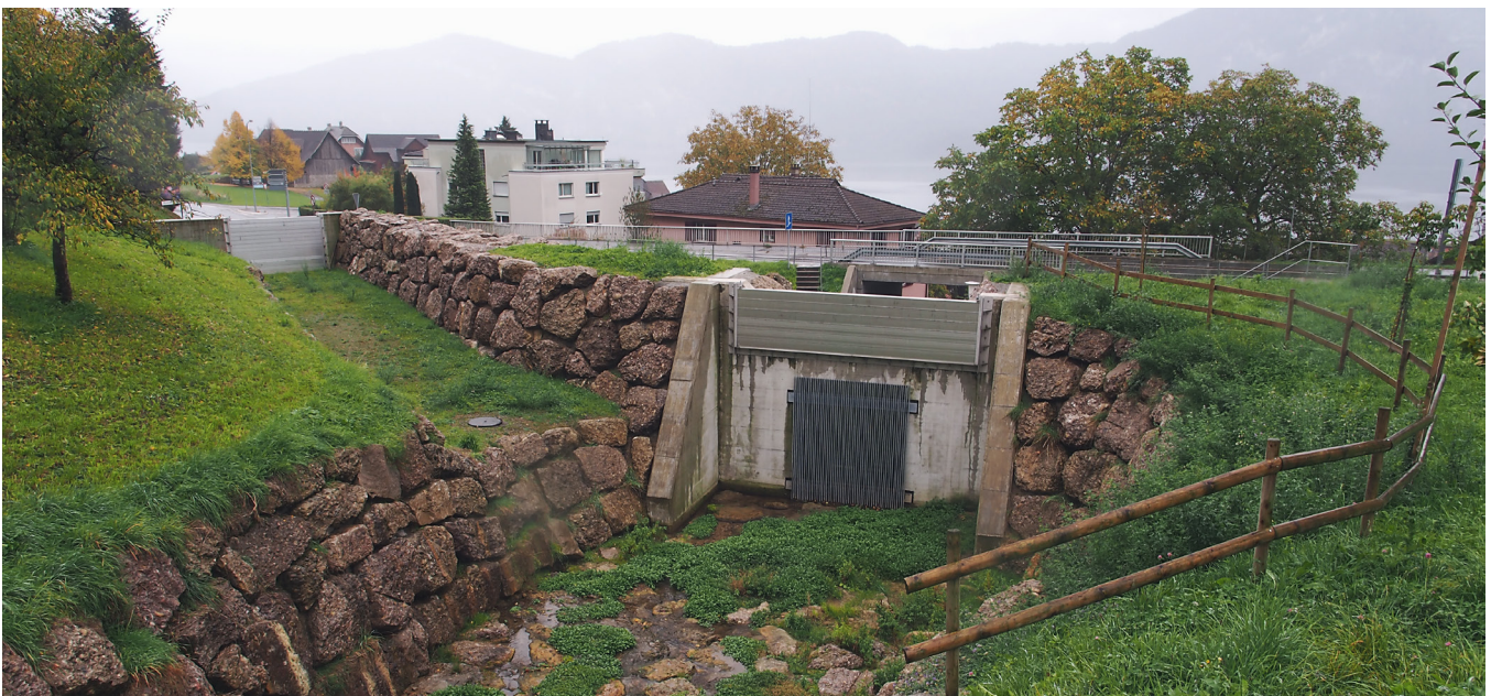
Dotierbauwerk Blauweid, Rubibach.
