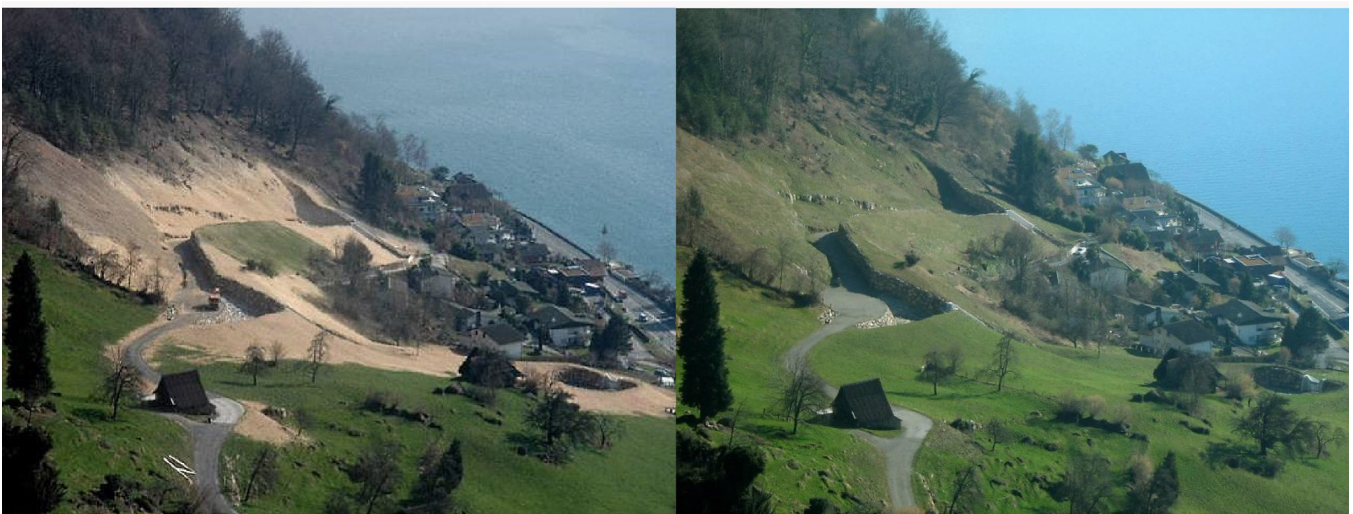
Schutzdämme Laugneri vor und nach der Begrünung. Fotos vom März 2007 und Februar 2008. The protection dams in Laugneri before and after greening. Photos taken in March 2007 and February 2008.
